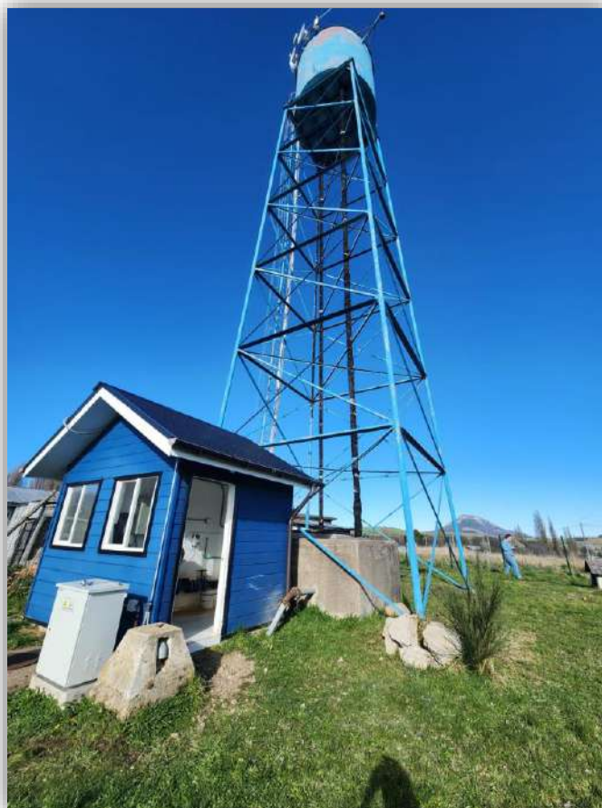
Figura 2-8: Estanque de regulación
